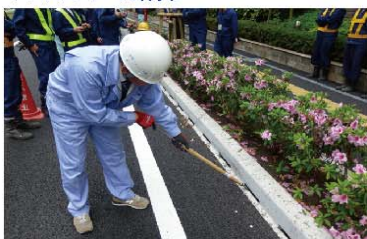
▼スリットの清掃
